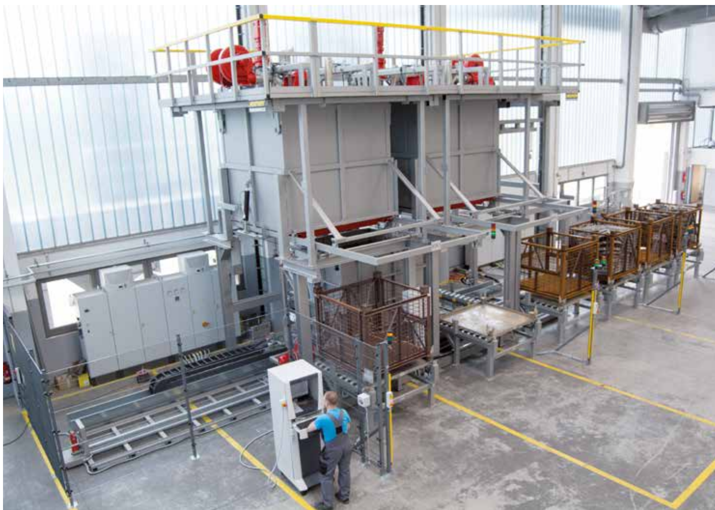
Impianto totalmente automatico di forni a caduta costituito da due forni a caduta, un bagno ad acqua traslabile e più punti di caricamento e prelievamento
