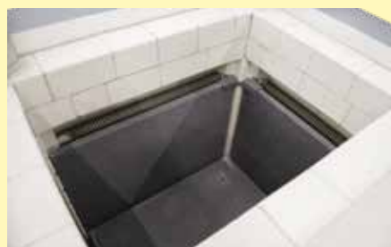
Auskleidung der Seiten und Boden mit Schutz aus Siliziumkarbidplatten bei Schachtofen S 73/HS
